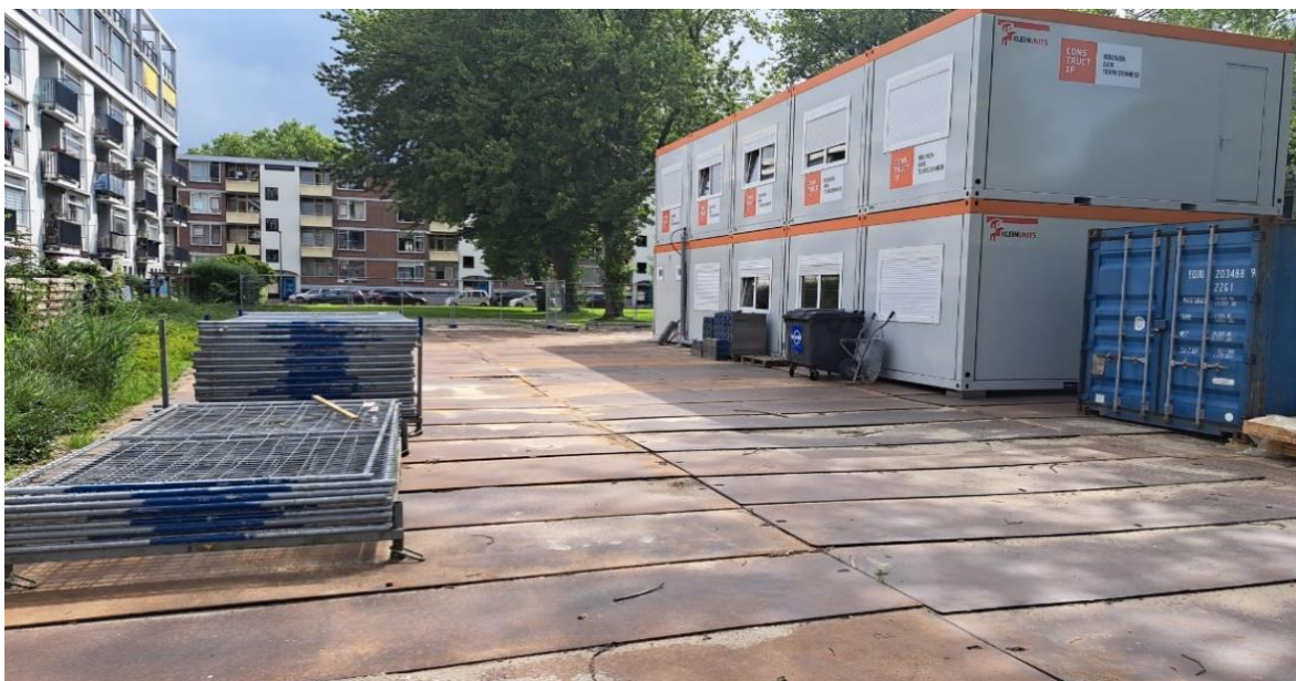
Foto van de bouwplaats met de containers
